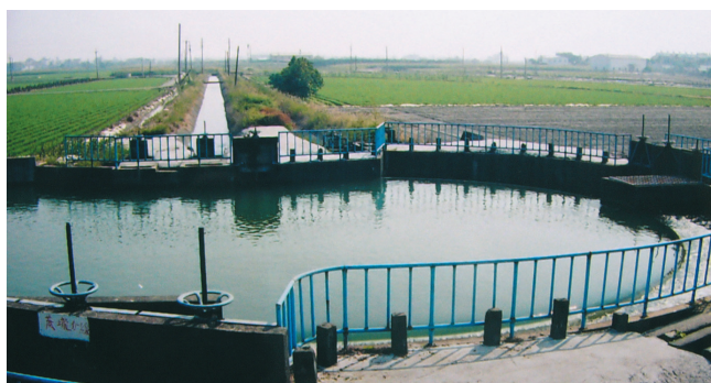
写真-13 四方に供給する分水堰 (嘉南農田水利会：提供)
