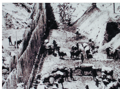
写真-9 水牛による締固め(古川勝三氏： 提供)
