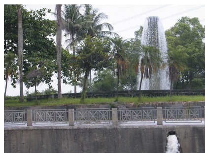
写真-4 水圧調整を兼ねて工夫された噴水
