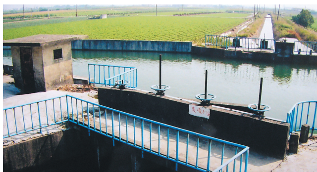
写真-14 幹線からの分水堰 (嘉南農田水利会：提供)
